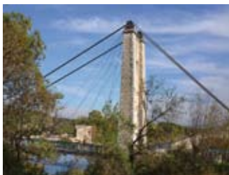
Pont de Saint-Martin
