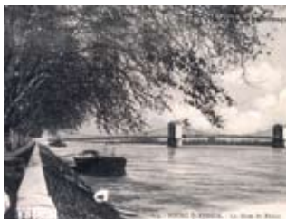
Pont de Bourg-Saint-Andéol
